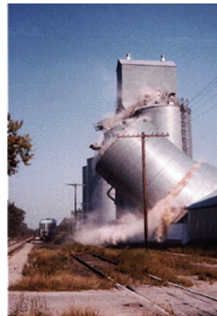
Abb. 1: „Silobeben“: Granulatgefüllte Silos können an unvermuteter Stelle plötzlich auseinander brechen (Foto aus [1]).
